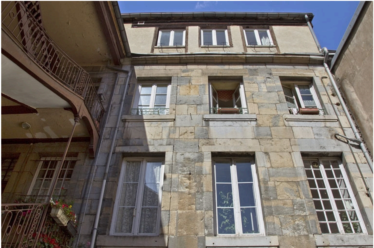
Logis principal, façade postérieure : de face.
