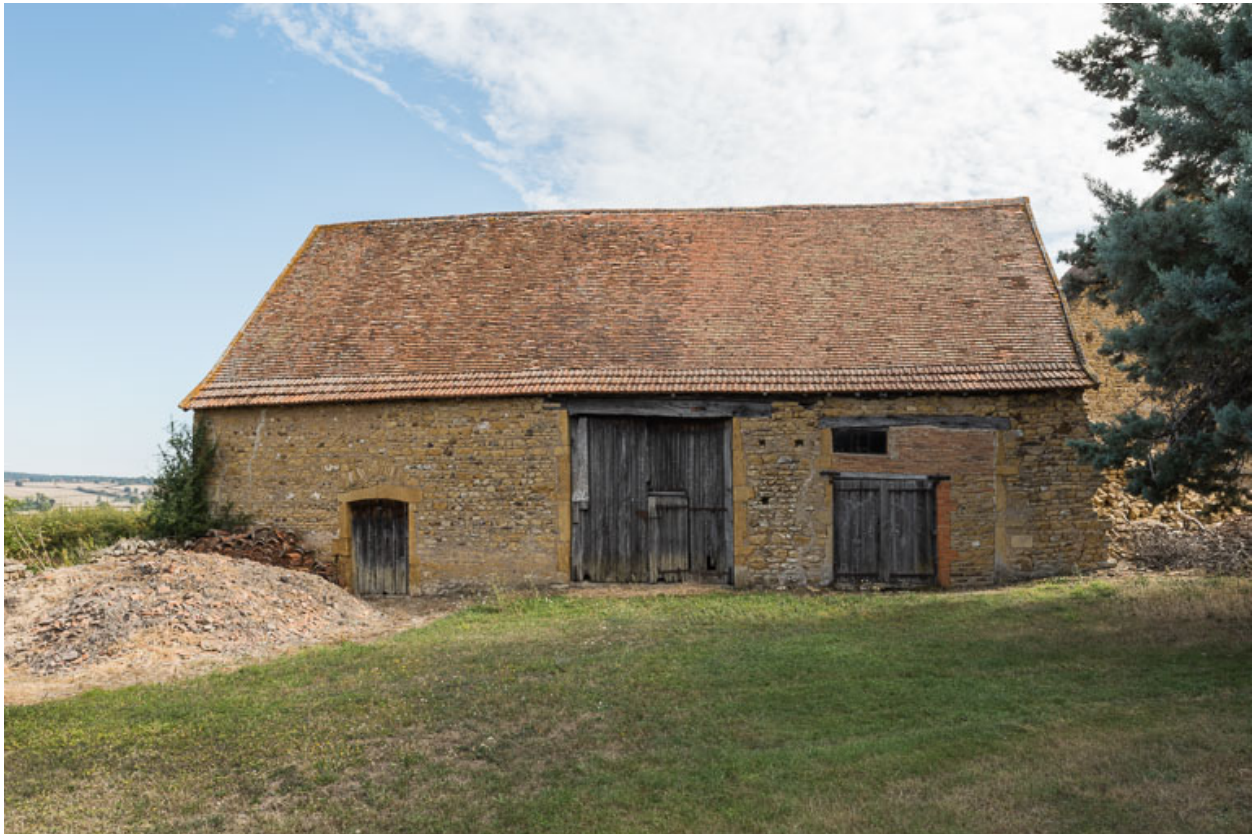
Façade antérieure de l'aile principale des dépendances, orientée à l'ouest
