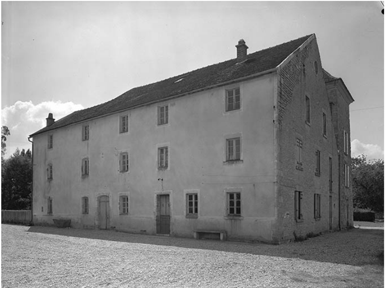
Vue sur le bâtiment principal.
