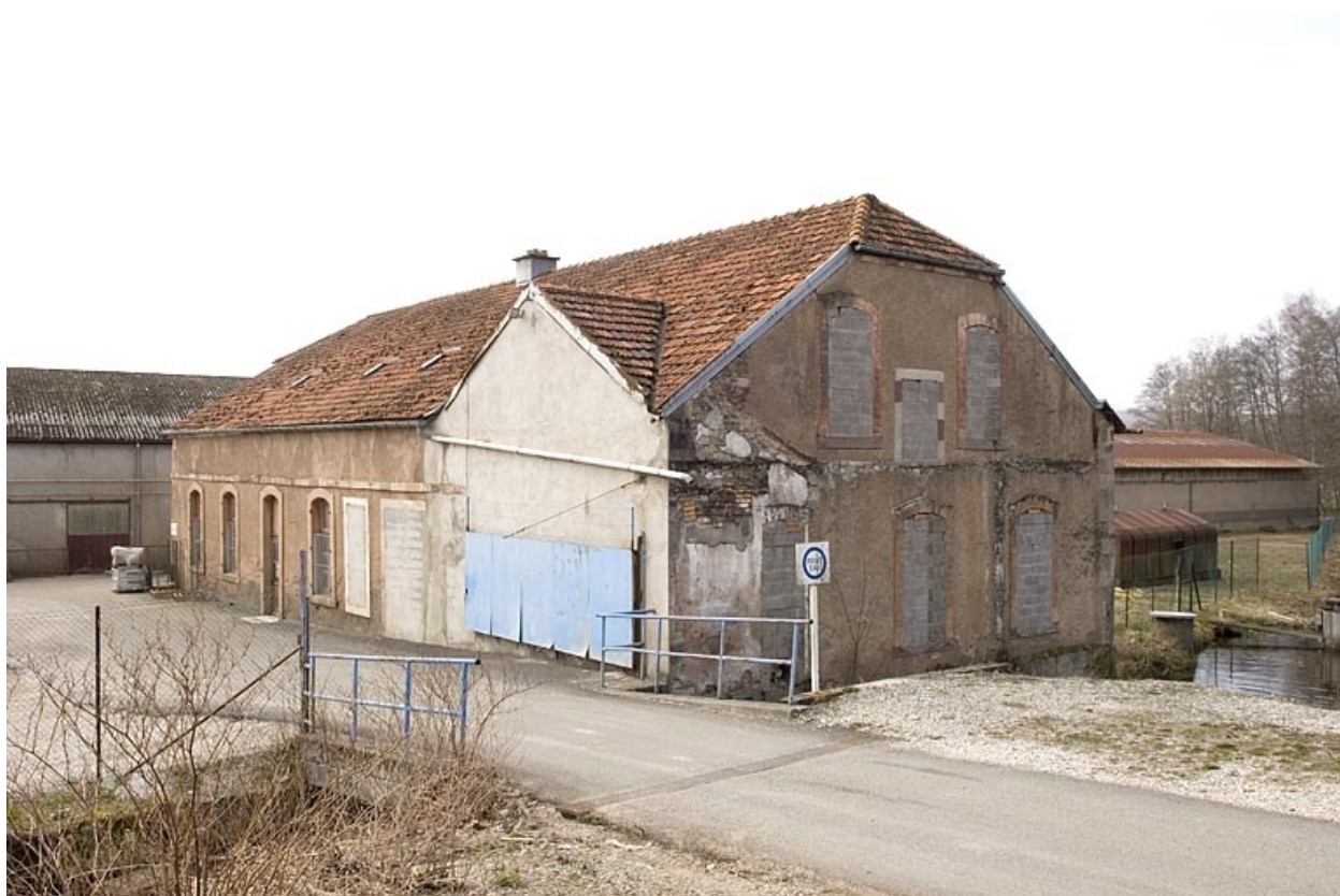
Moulin d'aval. Vue depuis l'est.
