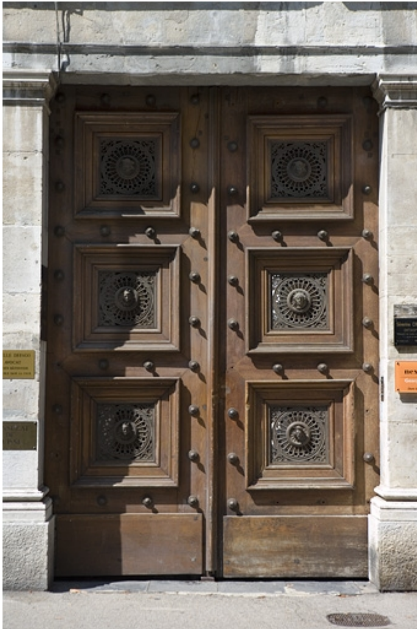
Façade sur rue : détail des vantaux en menuiserie du portail d'entrée.
