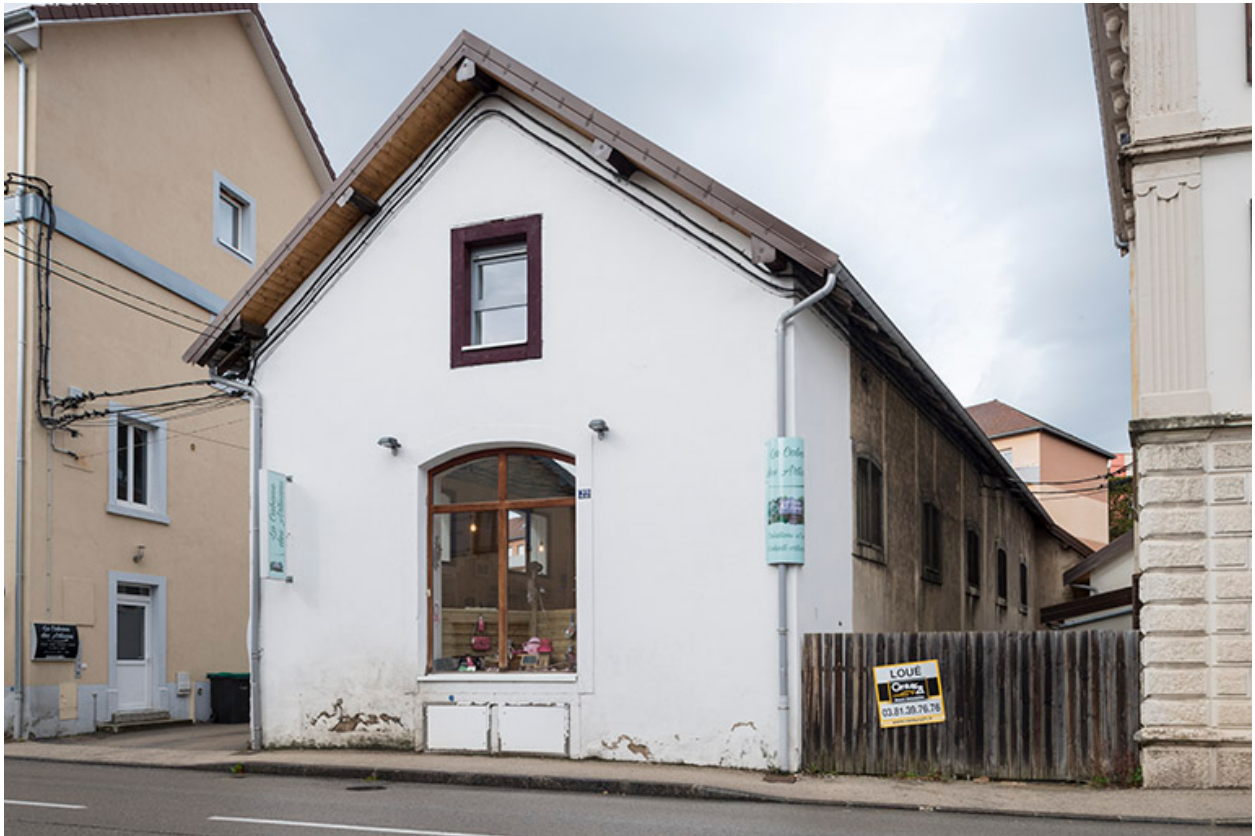
Pignon et façade nord.
