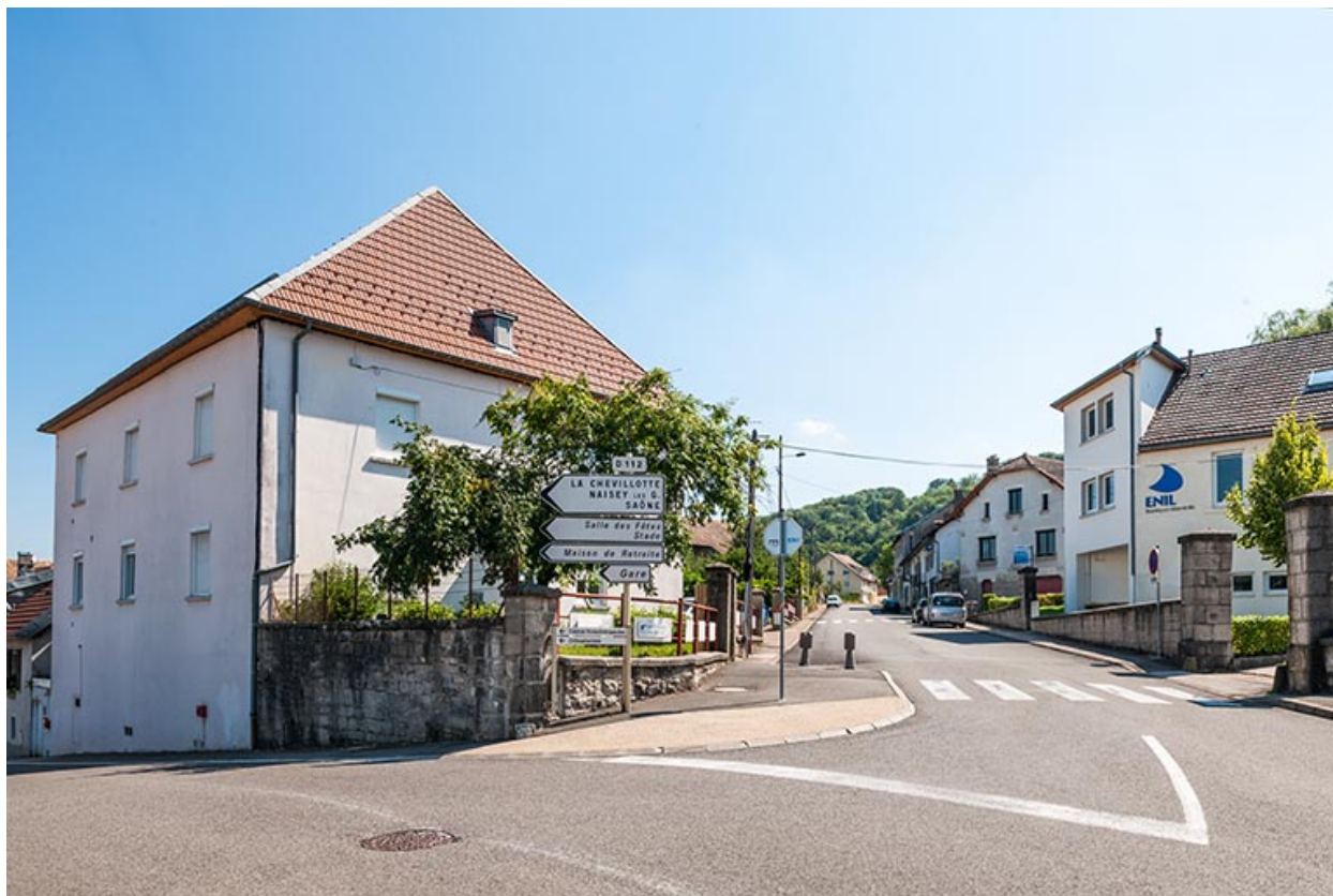
Angle ouest de l'annexe.
