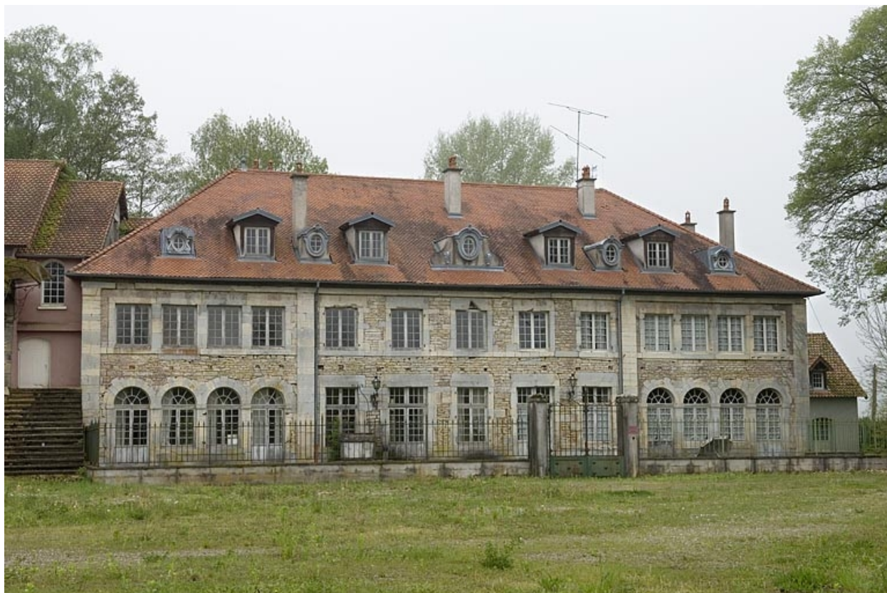
Logement patronal. Façade antérieure.
