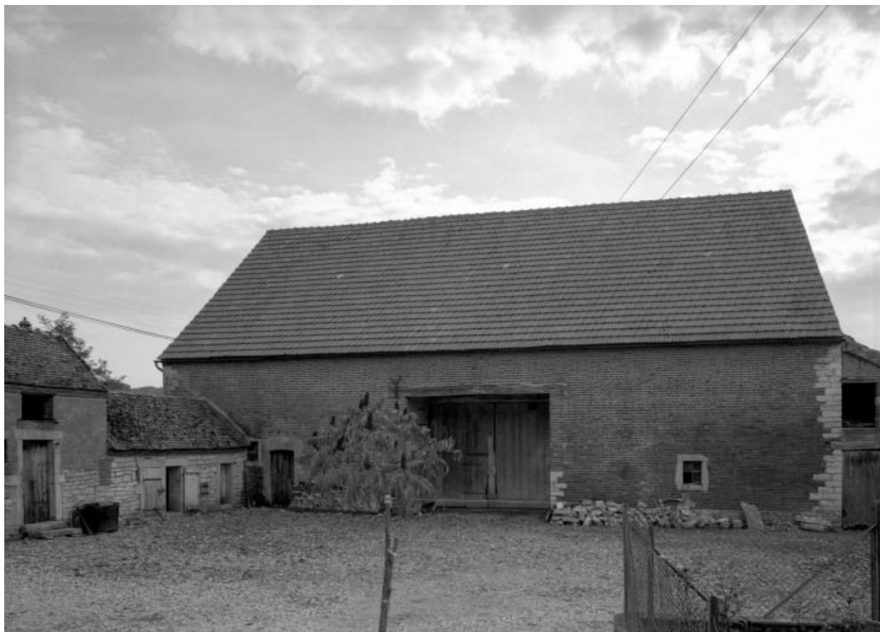
Bâtiment des dépendances.
