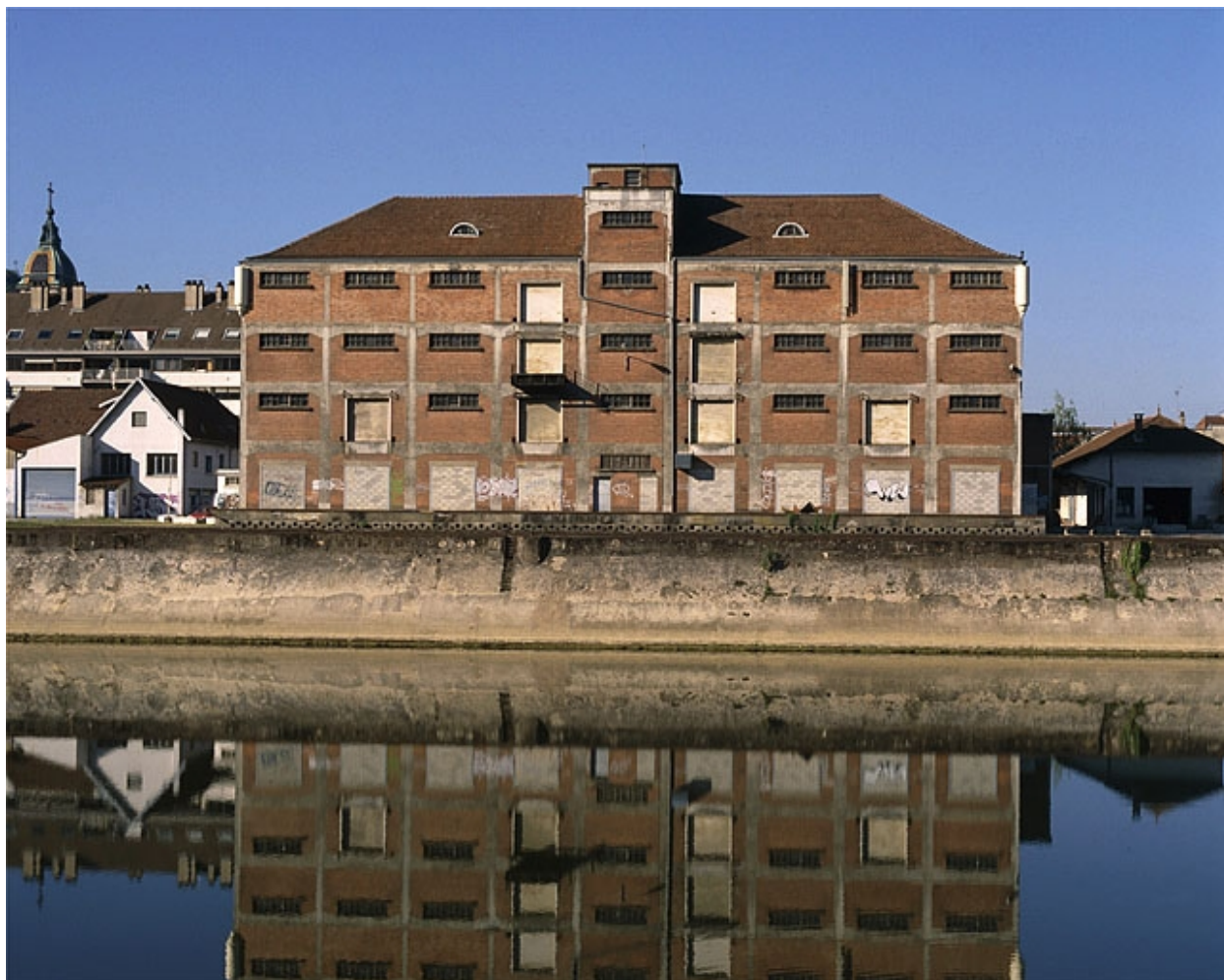
Entrepôt : façade postérieure (2003).
