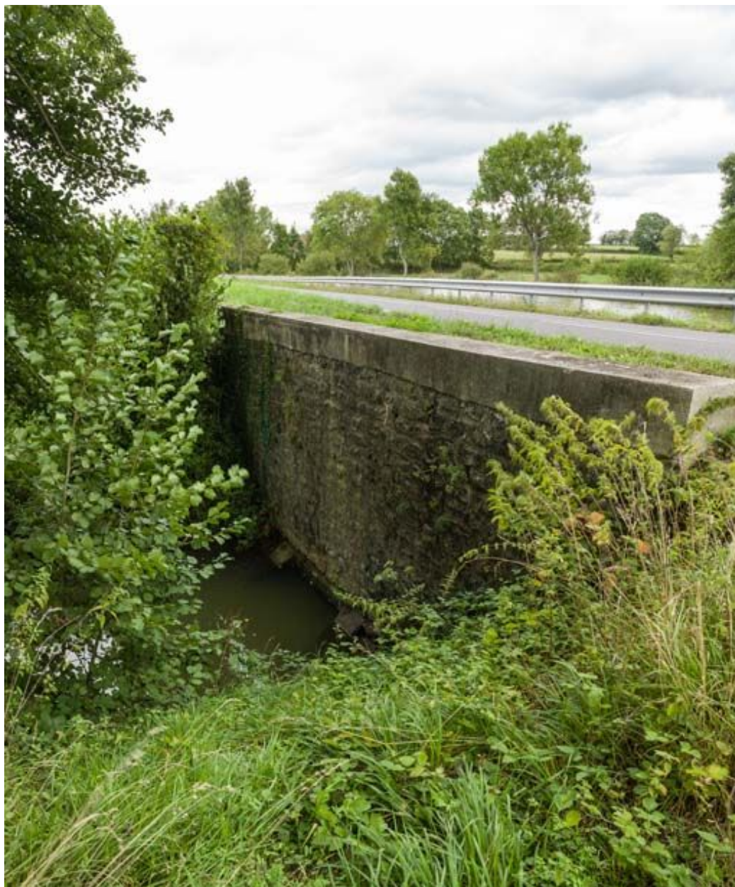
Vue de l'aqueduc.
