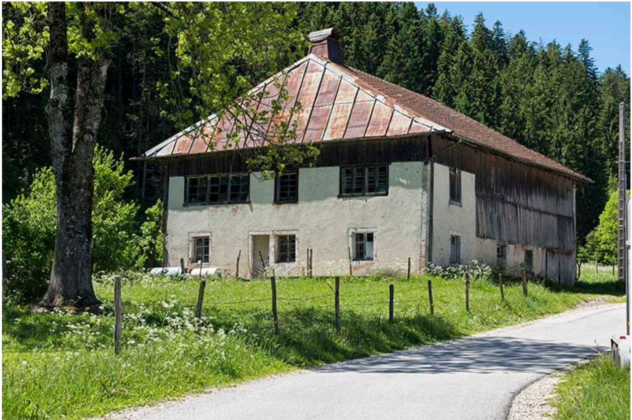
Façades nord et est.
