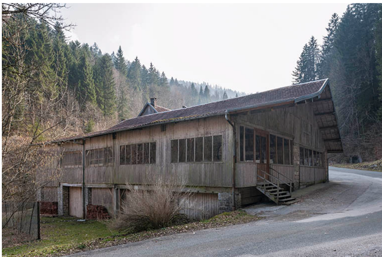
Atelier de scierie depuis le nord-ouest.
