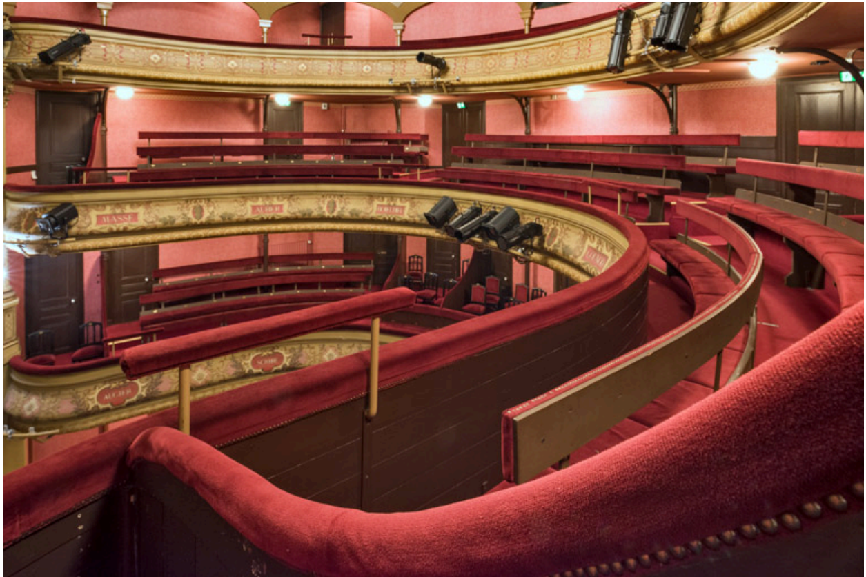
2e balcon, vu depuis le côté jardin.
