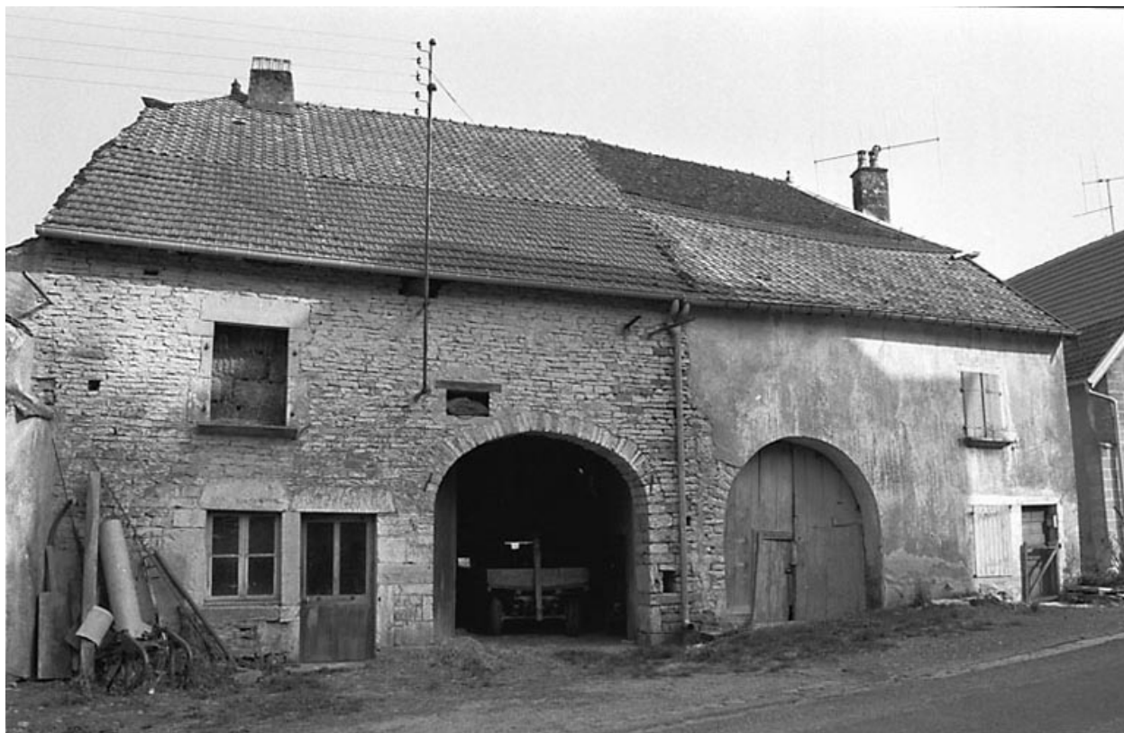
Ferme située 17 Grande Rue : façade antérieure.
