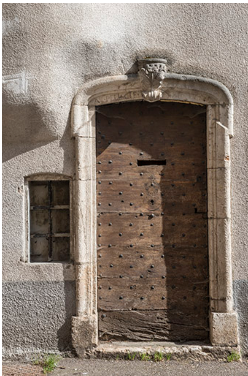
Porte avec linteau en arc surabaissé.
