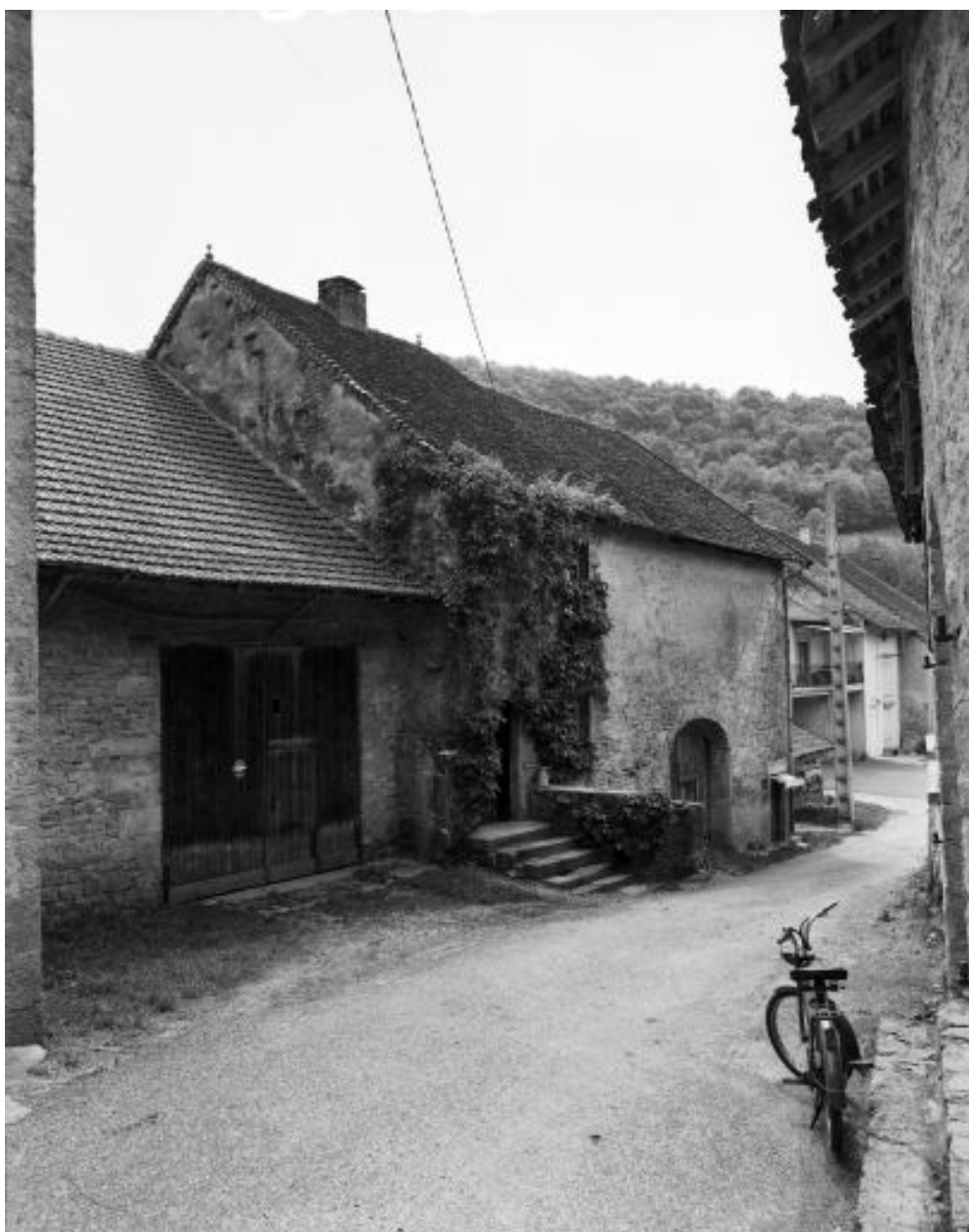
Ferme située rue du Fond de Vau : façade antérieure.
