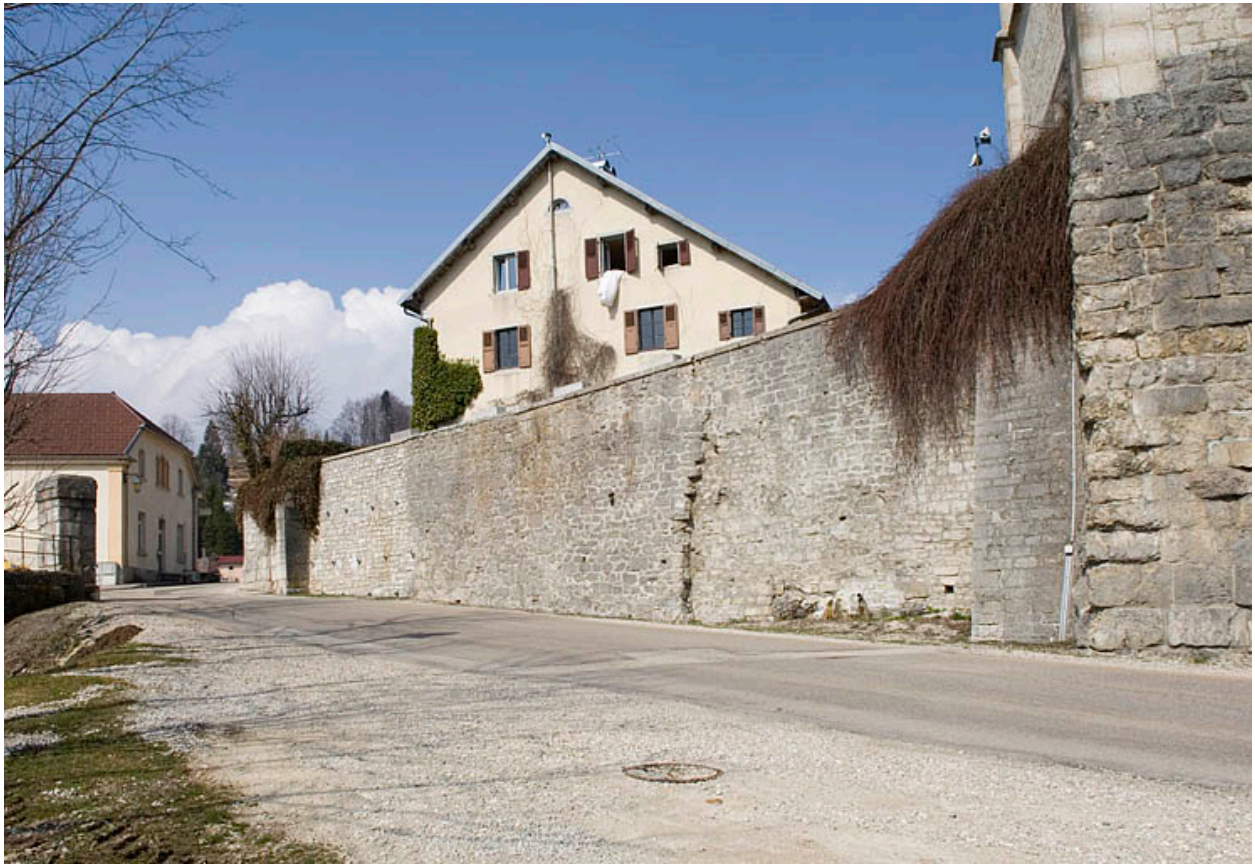
Porte sud et reprise moderne.
