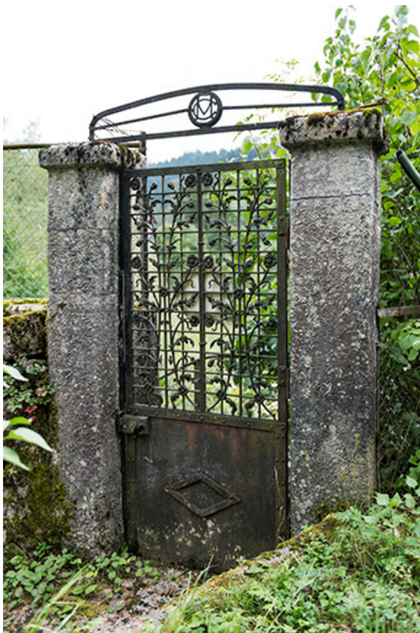
Porte de la clôture, au sud-est.
