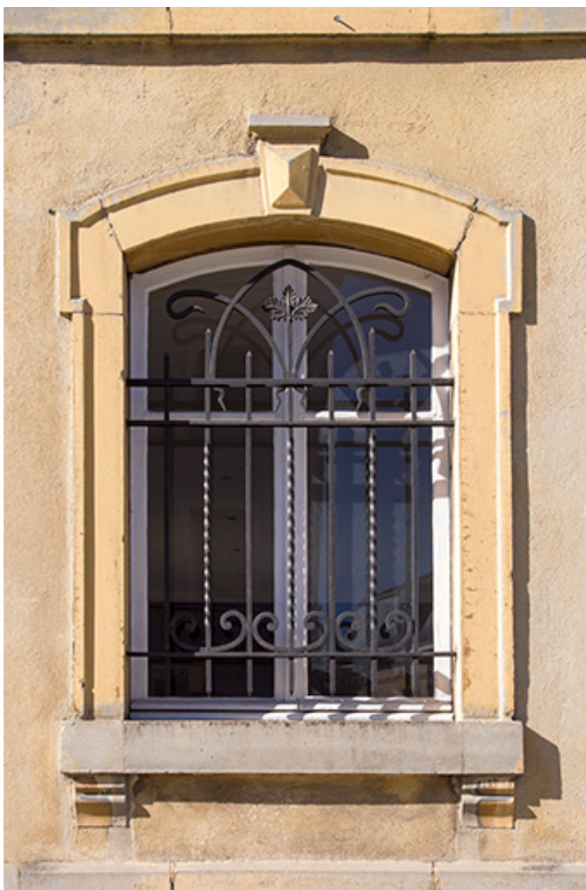
Fenêtre du corps de bâtiment occidental.
