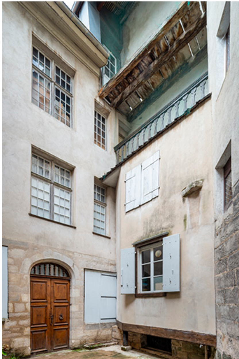
Ailes ouest et nord depuis la cour.
