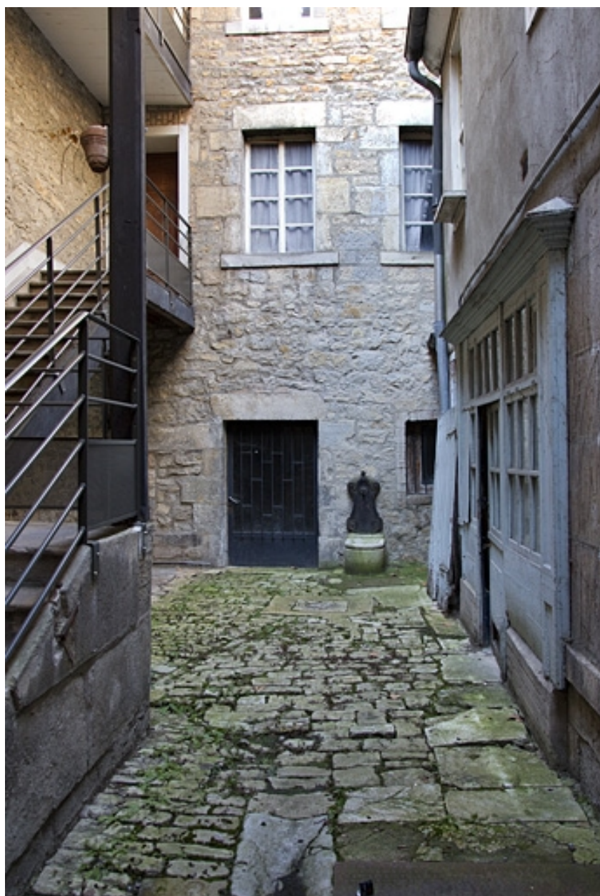
Vue d'ensemble du logis secondaire sur cour.
