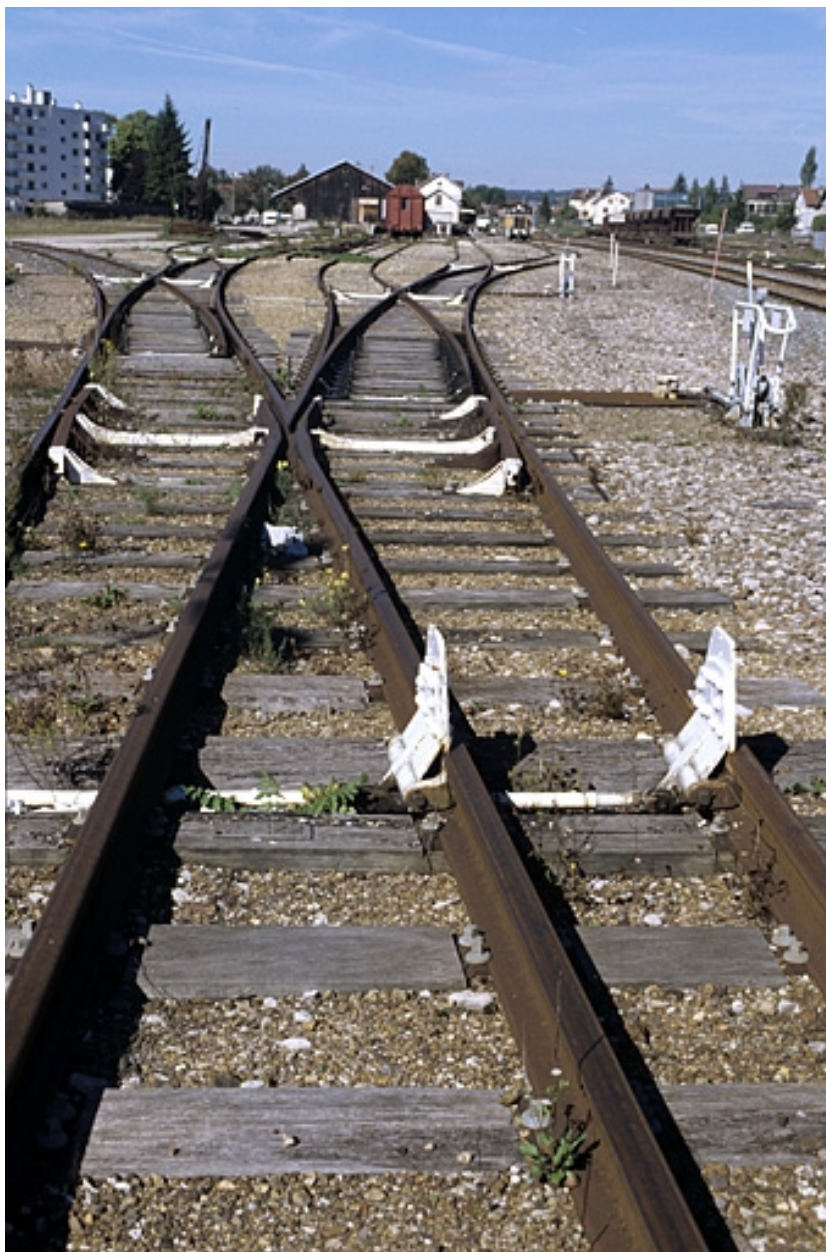
Gare de Champagnole : vue d'ensemble des voies de service ouest, avec les taquets d'arrêt au premier plan.
