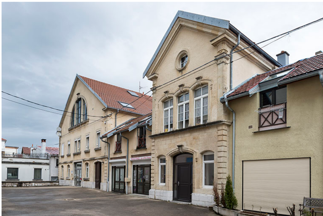
Façade des chais et entrepôts. Vue partielle.
