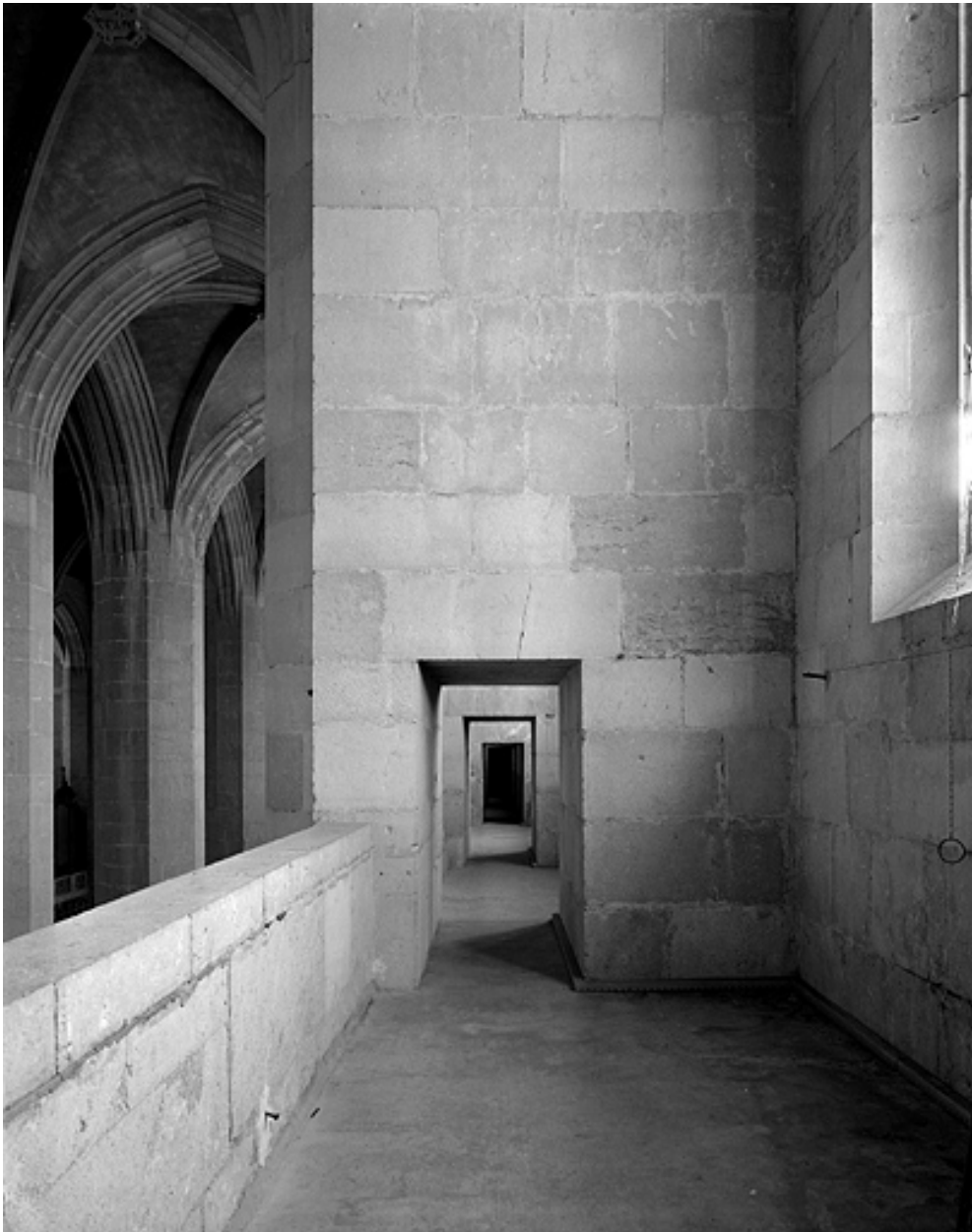
Vue de la coursière du collatéral sud à partir de la troisième travée.
