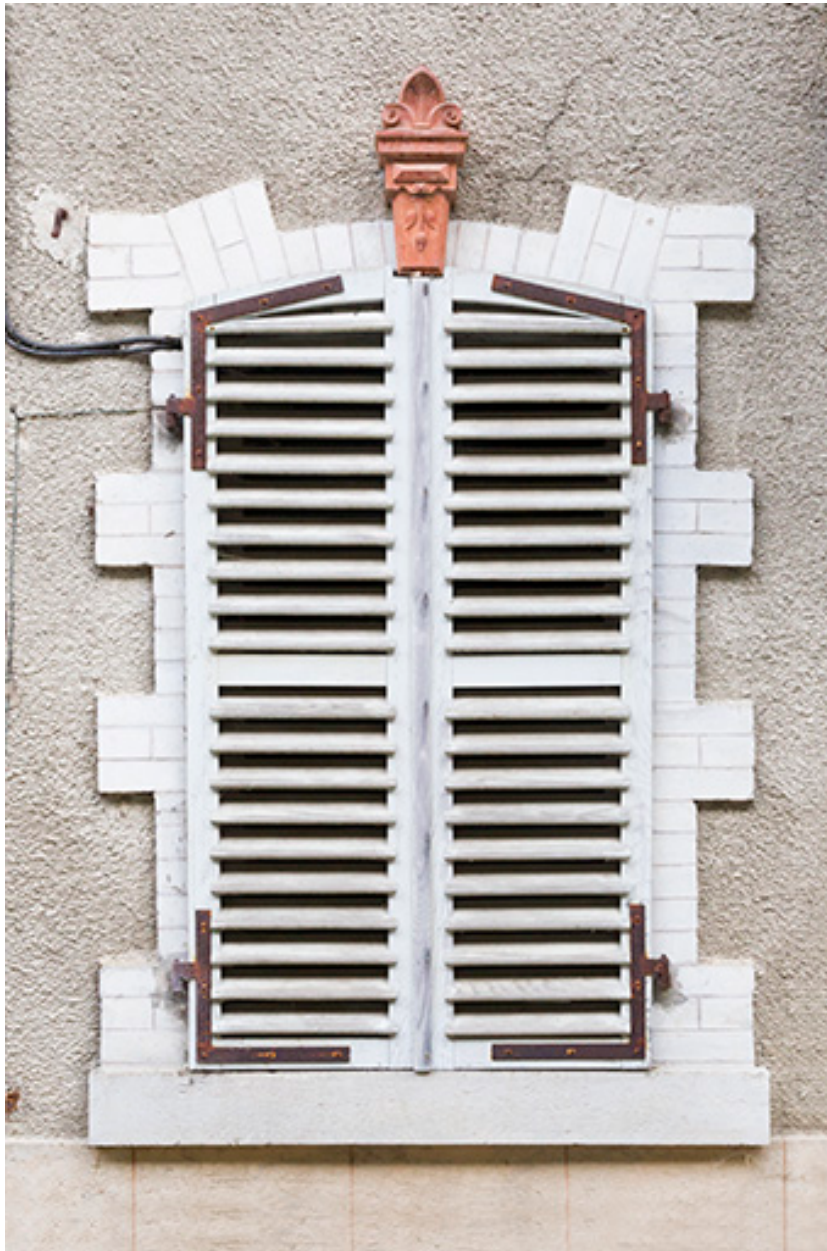
Logement patronal de 1900, façade antérieure : une fenêtre.
