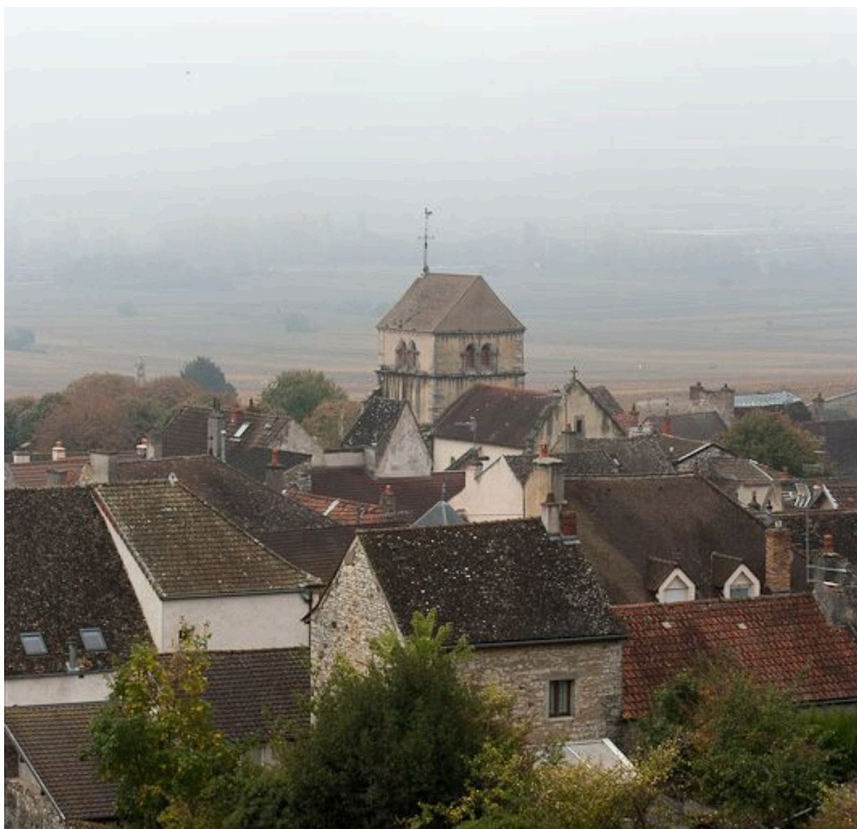
Eglise et site.
