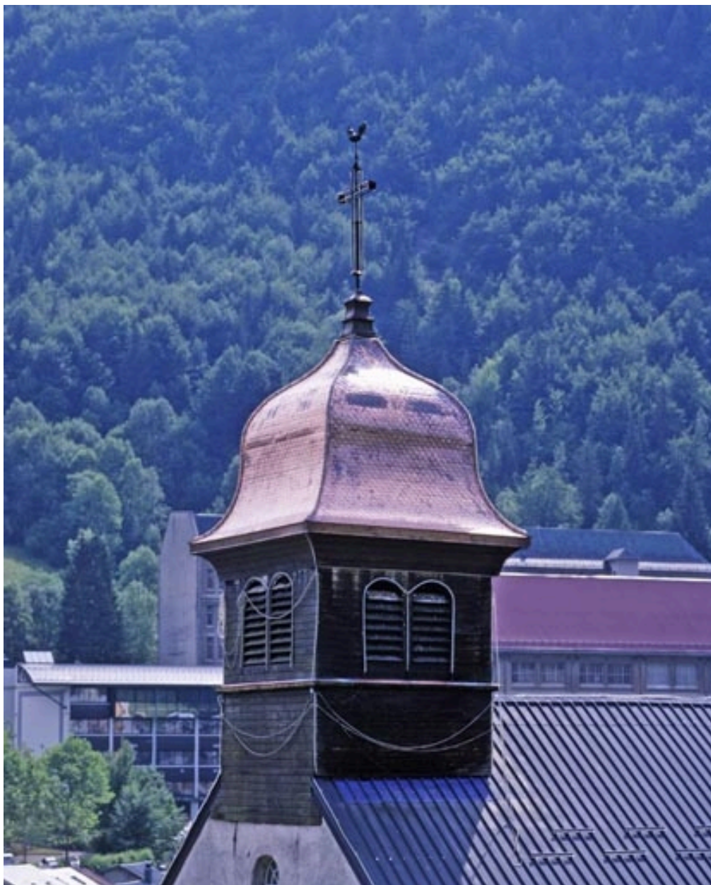
Clocher, depuis le nord-ouest.
