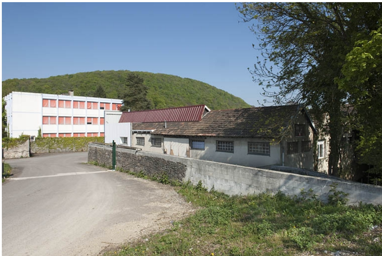
Bâtiment de bureaux et ancien atelier d'émaillage.
