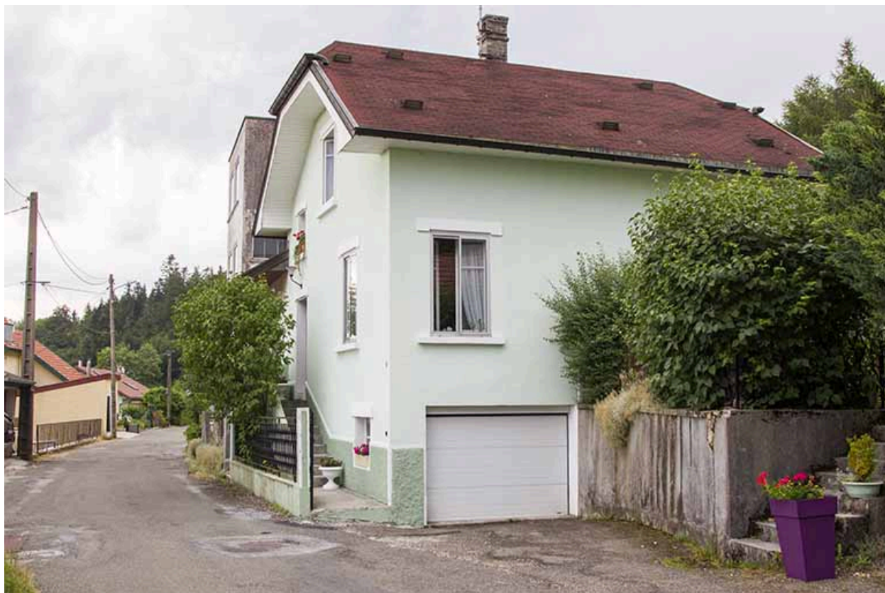
Logement et rue des Clos Magnin.
