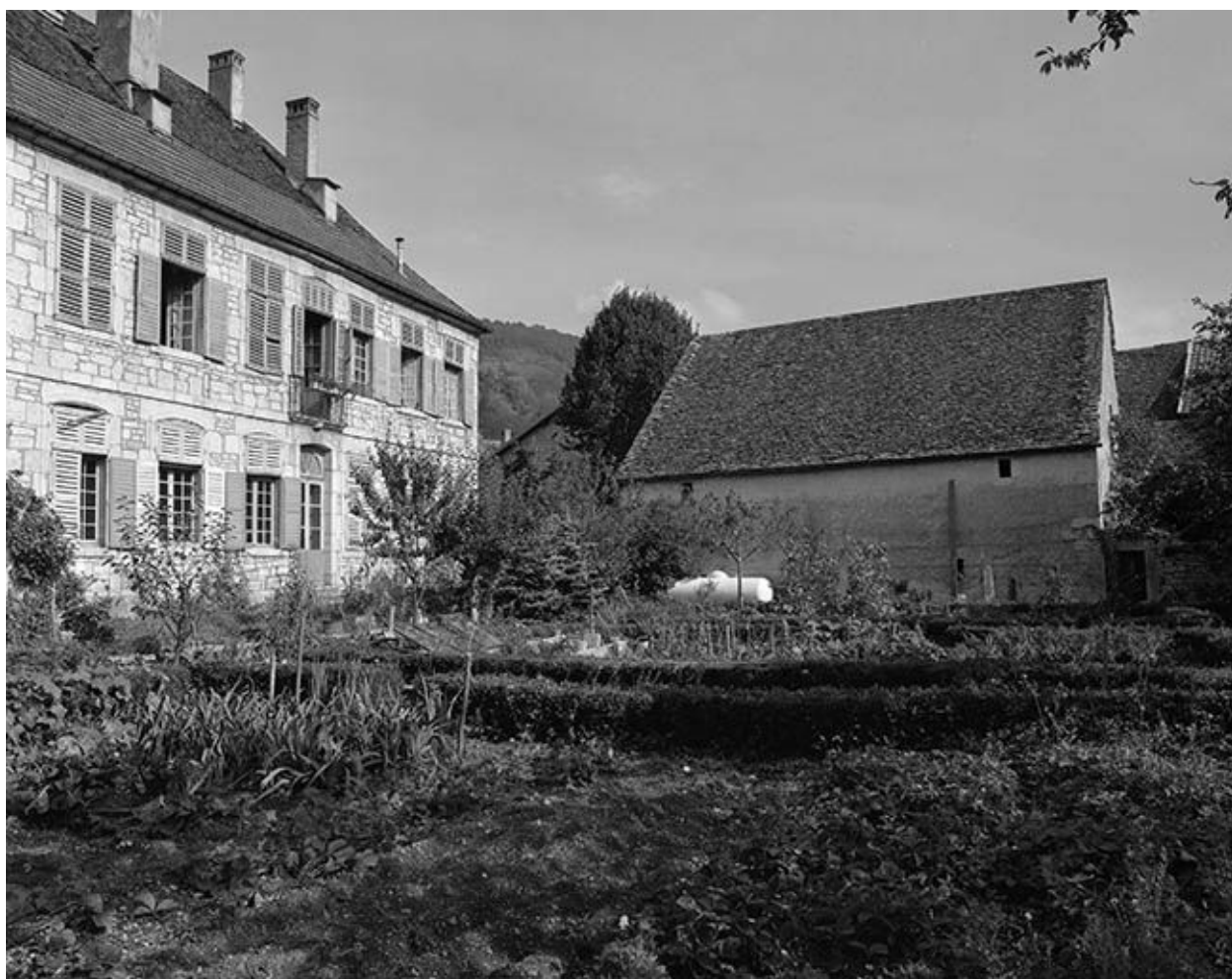
Vue d'ensemble depuis le jardin.
