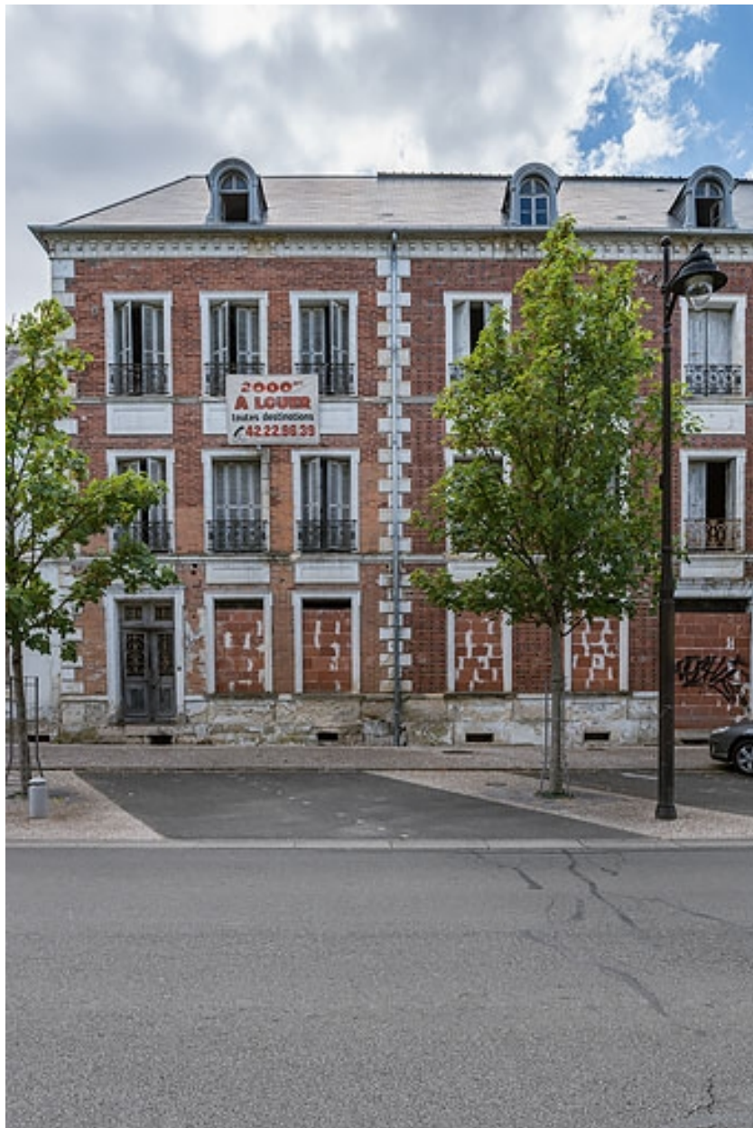
Façade de l'extension de Jules Guimard.
