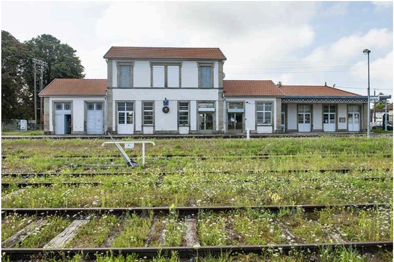
La gare, vue éloignée depuis les voies.
