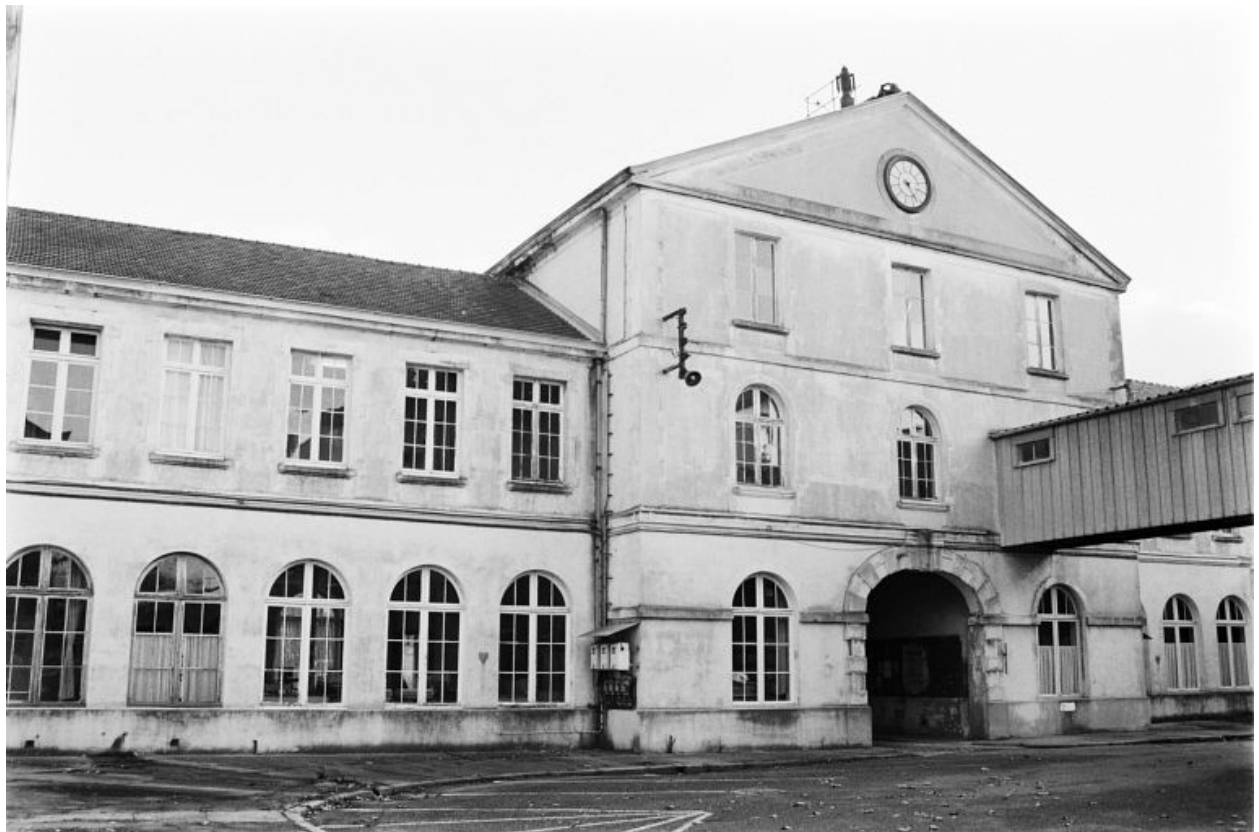
Façade postérieure des ateliers et bureaux centraux.
