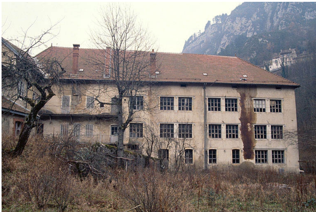
Façade postérieure de l'atelier de fabrication.
