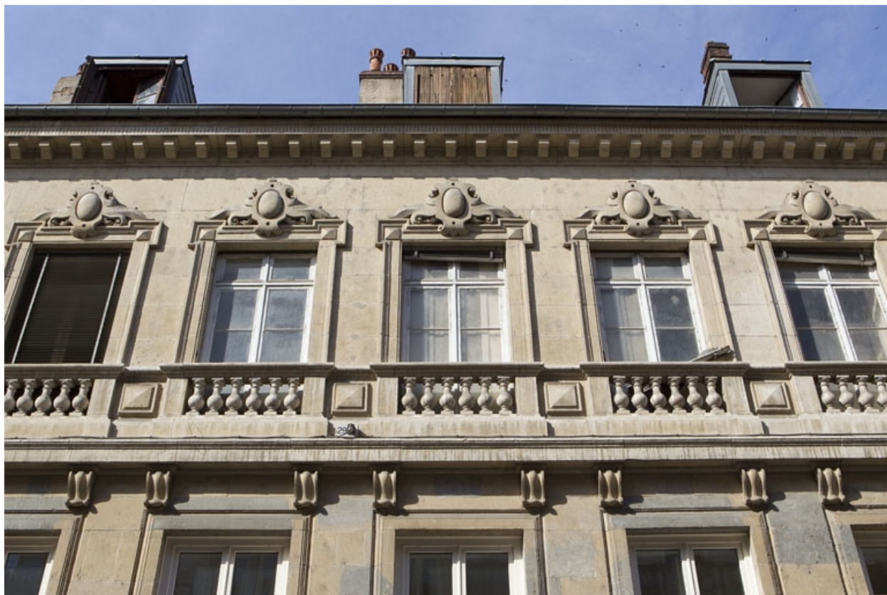
Détail des fenêtres du deuxième étage.
