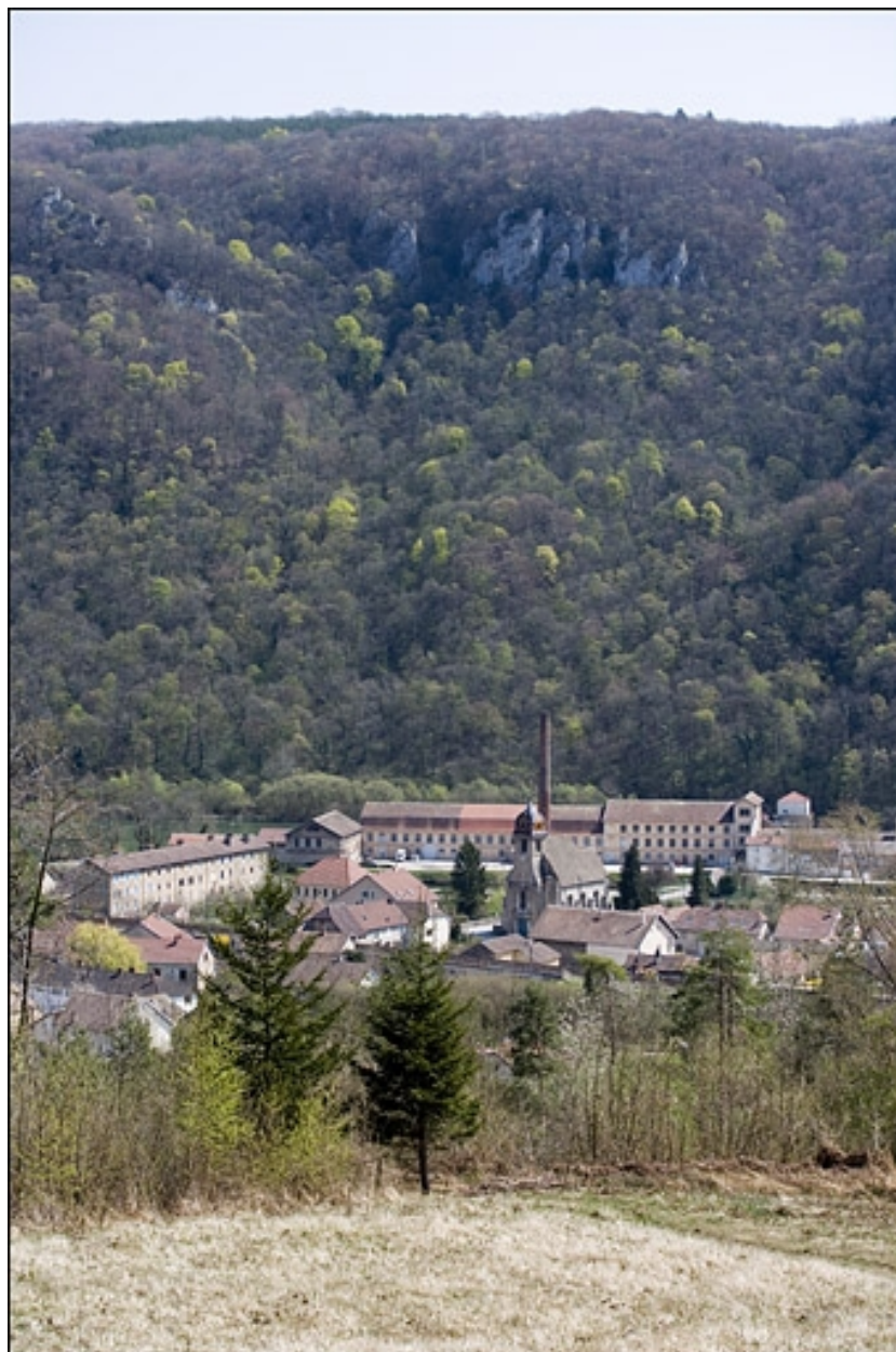
Vue plongeante depuis l'ouest.
