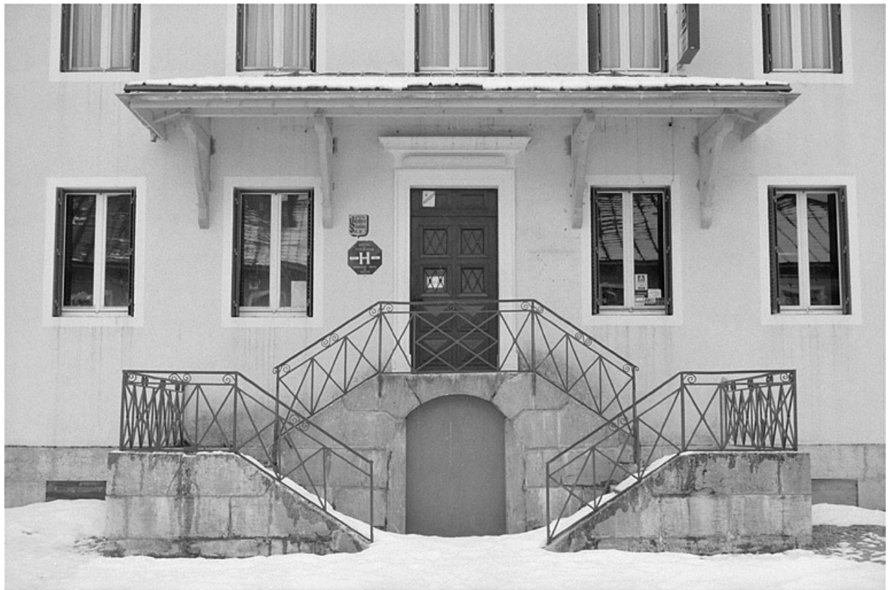
Escalier extérieur de l'atelier de fabrication.
