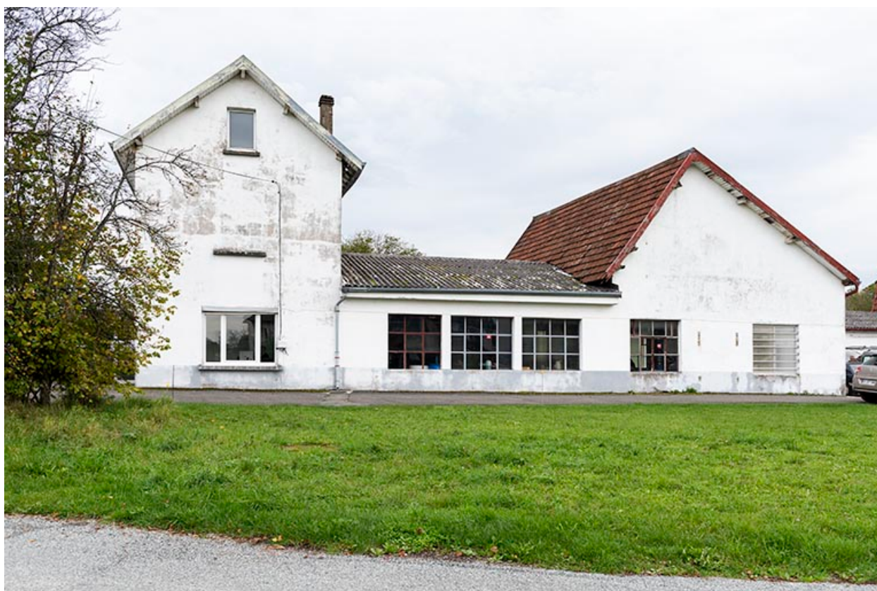
Bâtiments nord : façade latérale droite.
