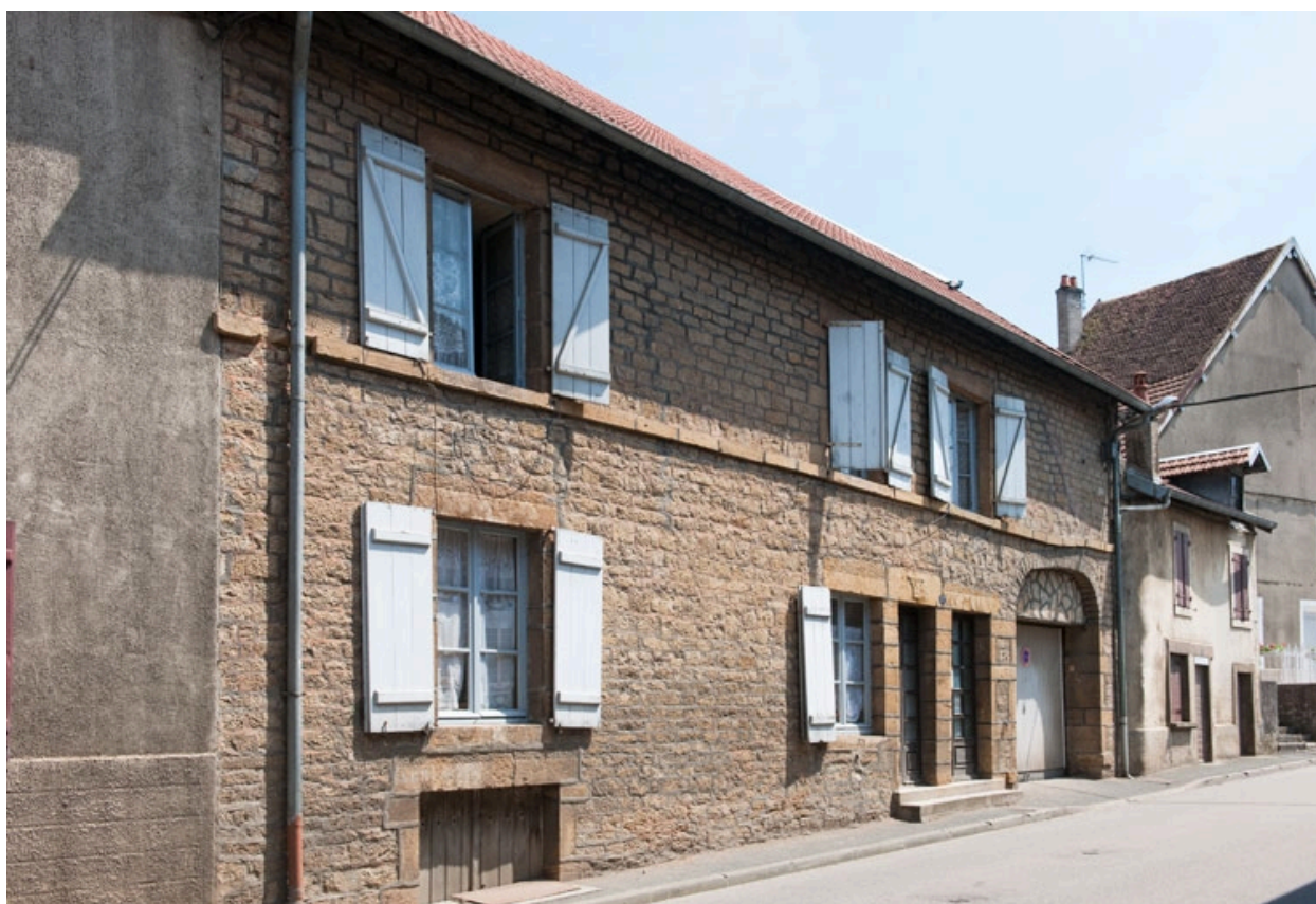
Façade antérieure, vue de trois quart gauche.
