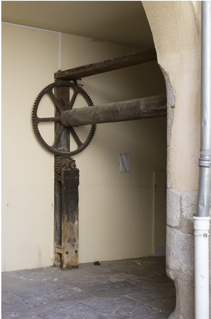
Détail du treuil pour monter et descendre les tonneaux dans la cave de l'immeuble.
