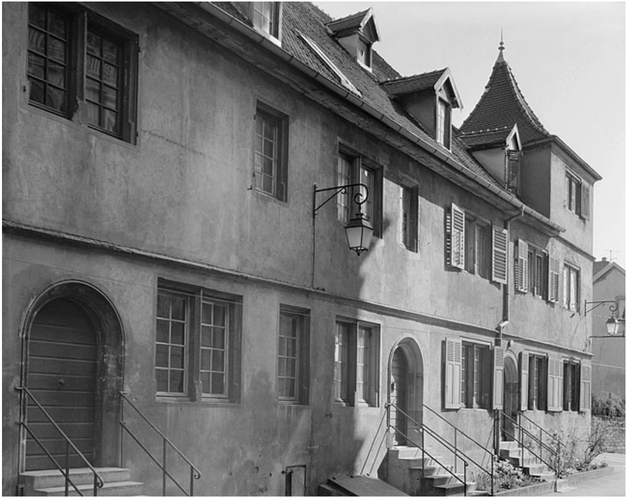
Aile nord de l'Université, façade sur l'ancienne cour.
