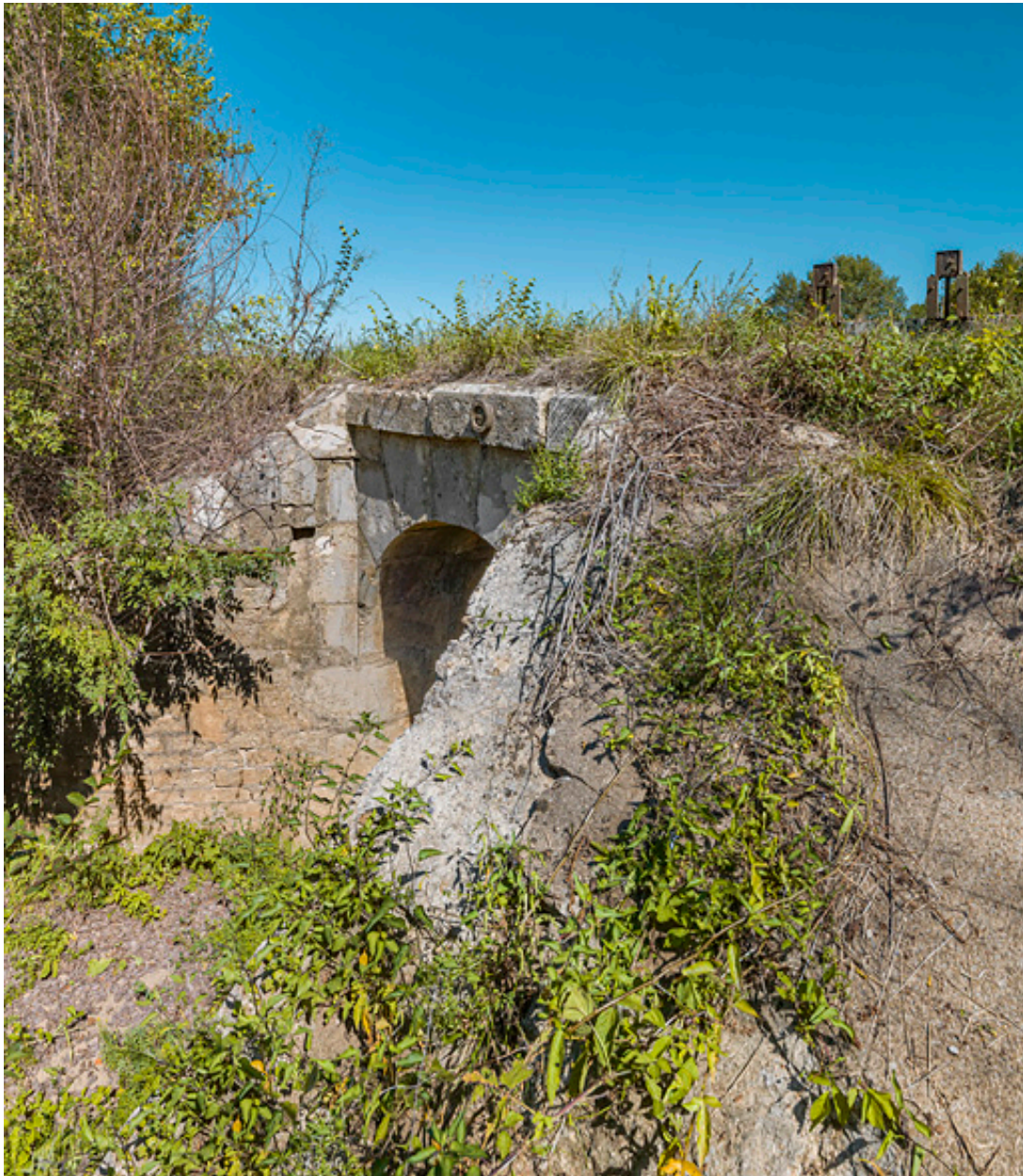
Vue d'ensemble du ponceau et des vanes, rive gauche.
