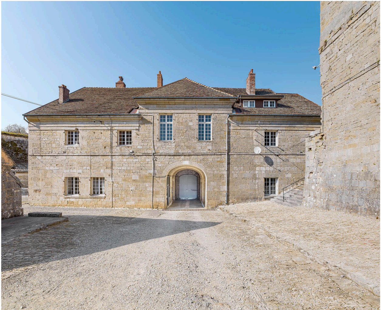
Pavillon d'entrée : façade postérieure.
