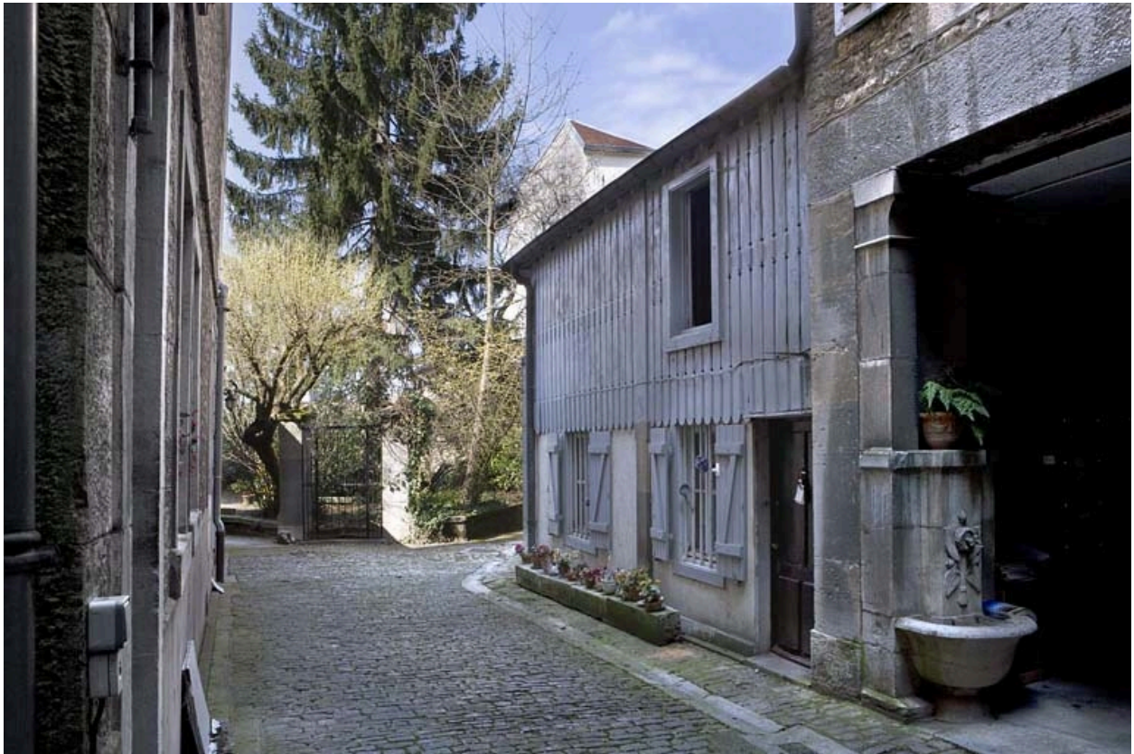
Vue d'ensemble du séchoir avec habitation en rez-de-chaussée, de trois quarts droit.
