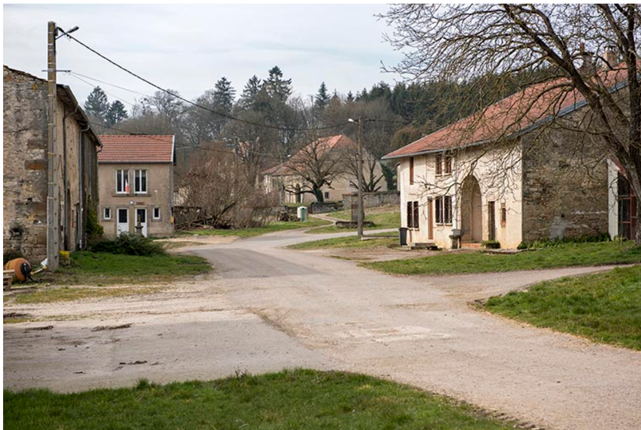
Rue du château vue de l'est.
