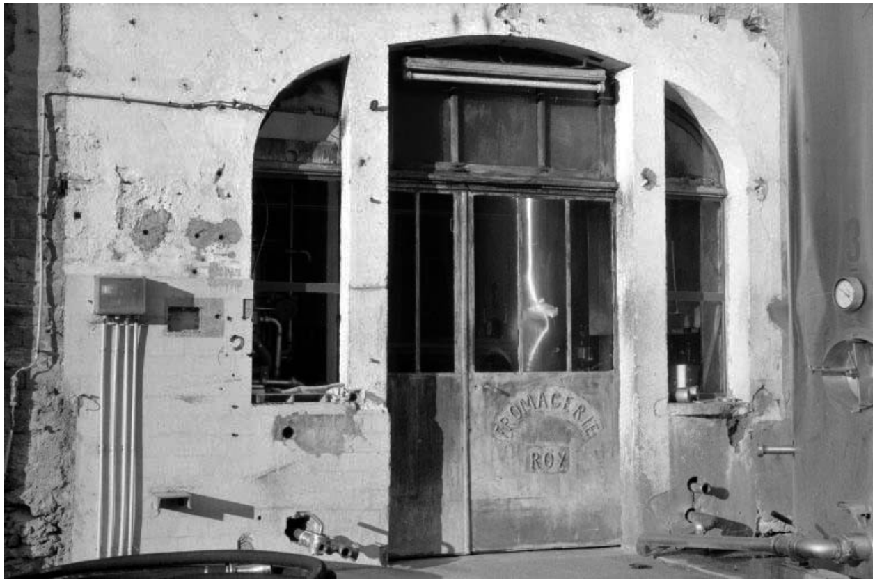
Porte d'entrée de l'atelier de fabrication.
