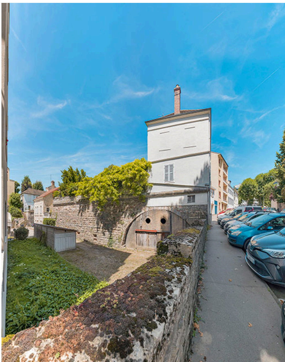
Flanc sud du bastion Saint-Paul.
