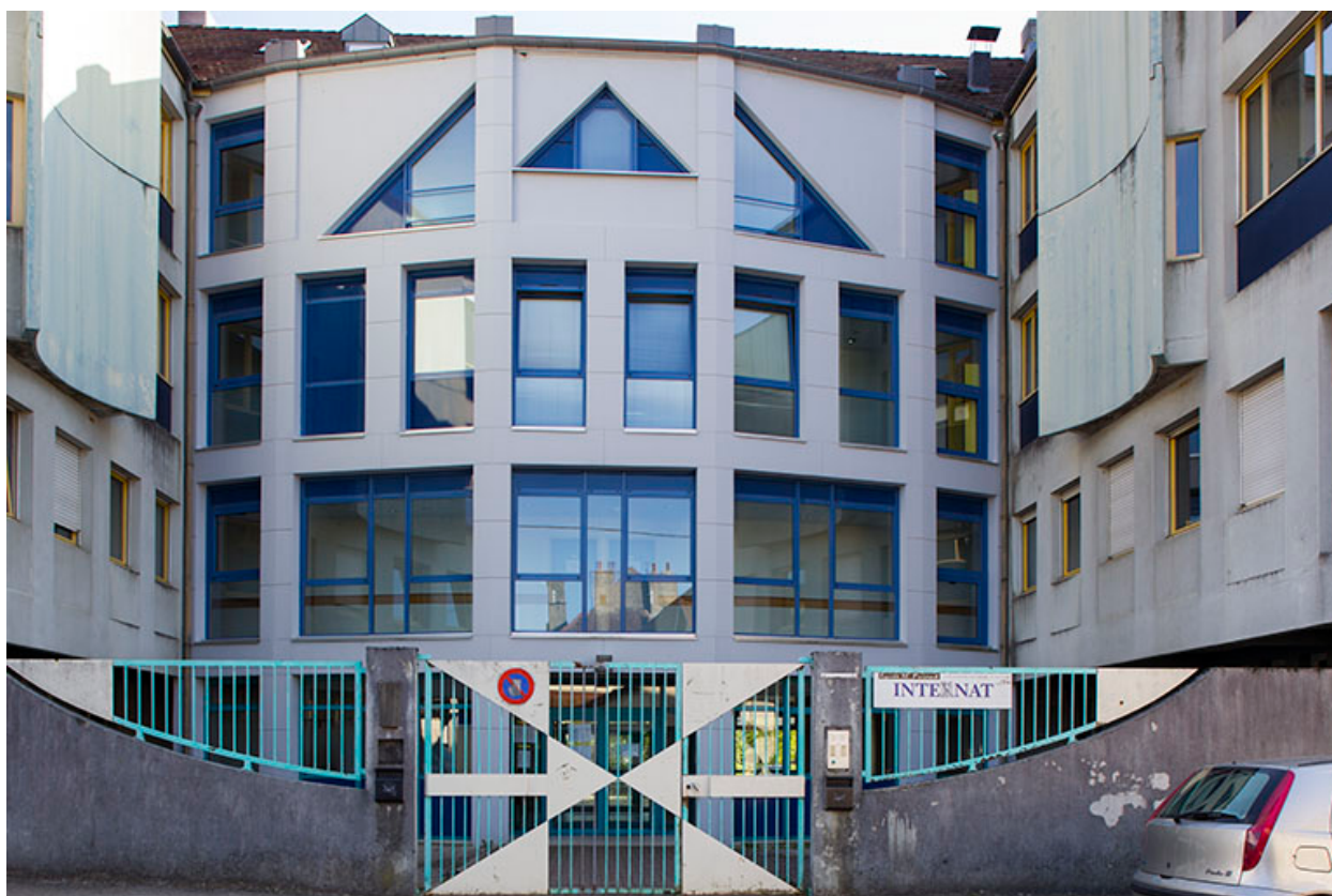
Internat : façade Nord, détail.
