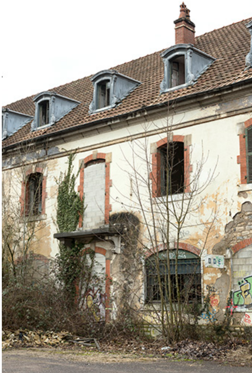
Etat en 2016. Usine A : travées de la façade sur cour des bureaux (extrémité occidentale).
